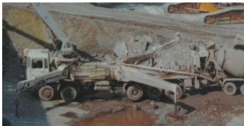
«Путцмейстер» М-52 в робочому положенні на будівництві «Укриття». Праворуч – бетонозмішувач (міксер).
